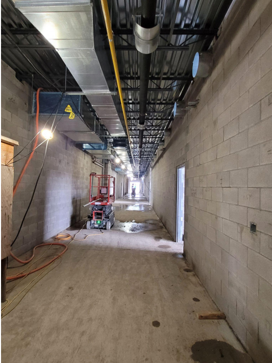
Corridor C115 (gymnases et locaux spécialisés)
