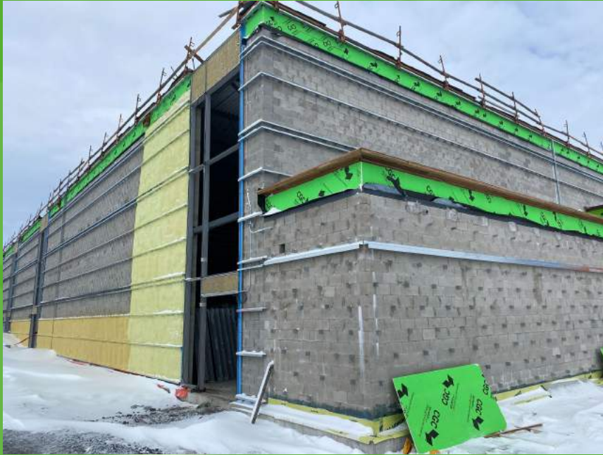
Construction des parapets du gymnase et entrepôt
