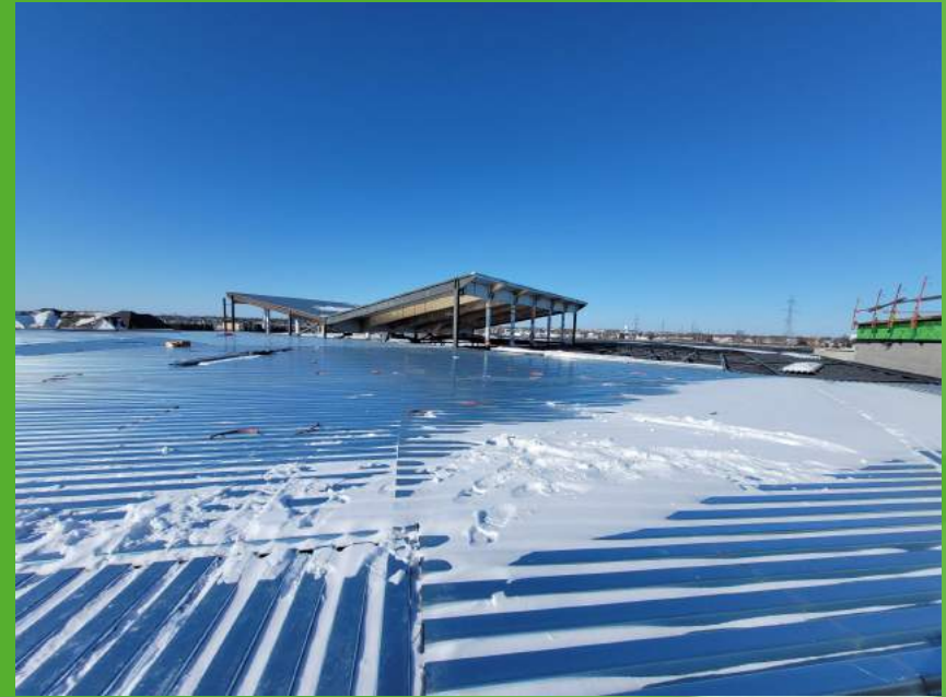
Toiture de la bibliothèque et atrium
