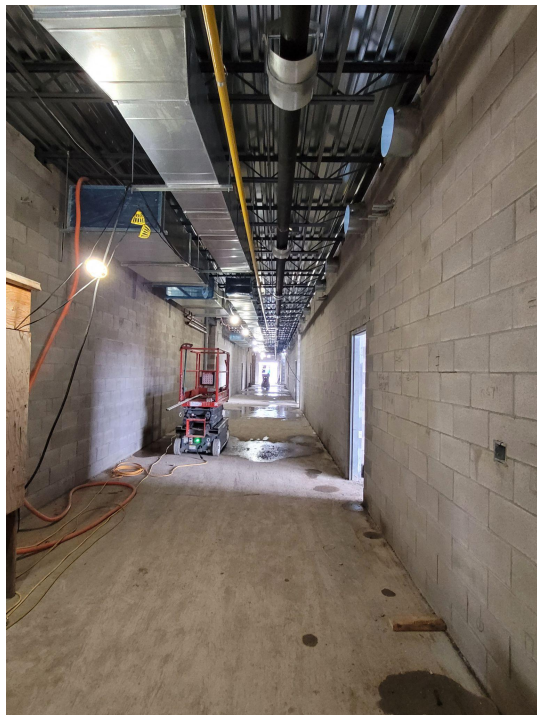
Corridor C115 (gymnases et locaux spécialisés)
